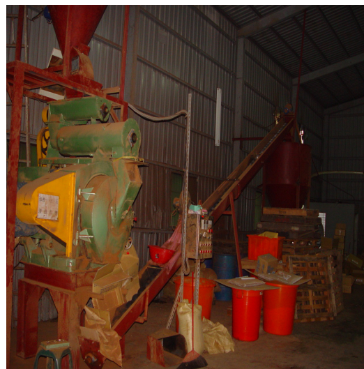
協助廠商進行功能性有機肥製造設備組裝生產流程
