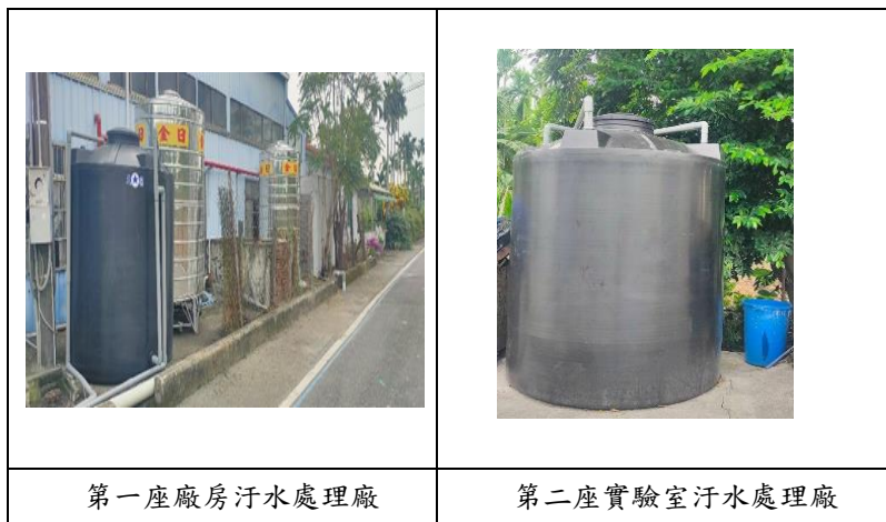
圖 4 汗水處理管線建置完成
