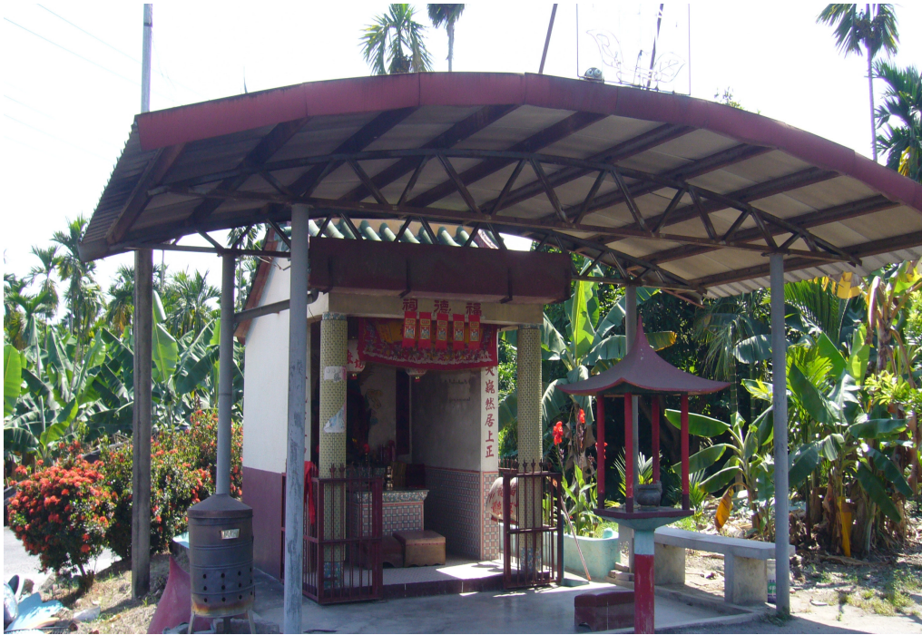
⑲ 下坡仔埤圳份橋伯公廟
