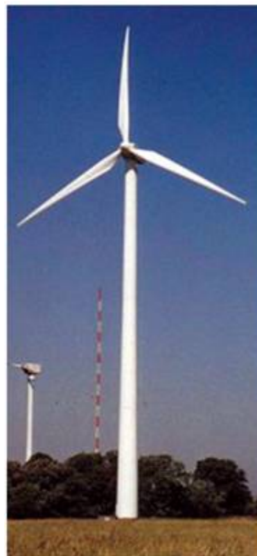
現代式百萬瓦級風力發電機。
