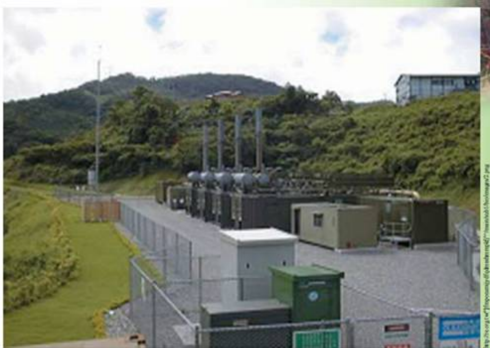
生質能的使用——台北市山豬窟掩埋場沼氣發電系統（5,448瓩）
