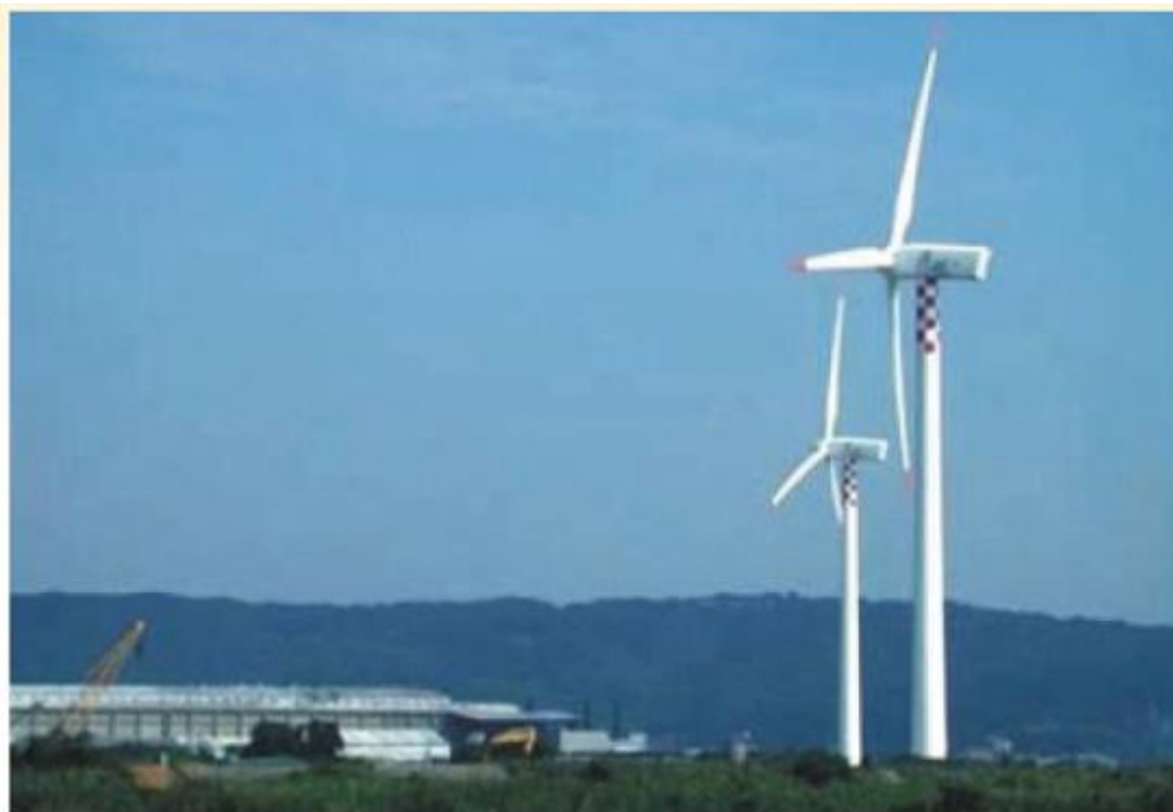
國內第一座千瓩級的風力發電機：竹北春風風力發電示範系統。
