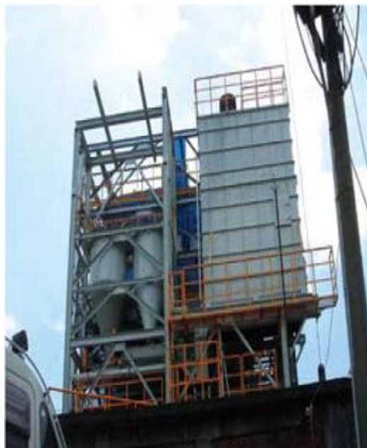
工研院所開發的RDF-5氣泡式流體化床蒸氣鍋爐，最大蒸氣產量是6公噸/時。
